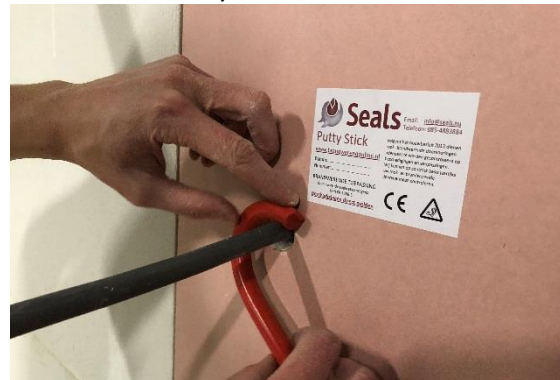
Bepaal grofweg de lengte -6 mm.
